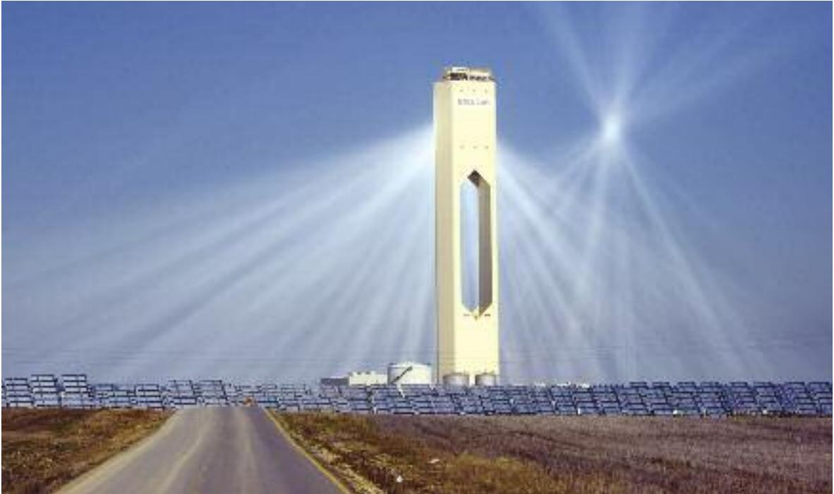
Antelope Valley - California. Impianto "sierra suntower", costituito da 24.000 specchi che riflettono la luce solare su due torri alte 50 metri per convertire il calore del sole in energia elettrica
