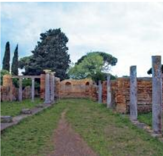
Terme delle sette colonne
