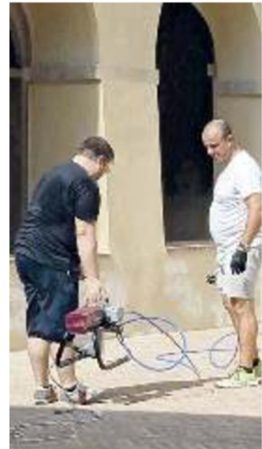
Le operazioni di pulizia del chiostro
